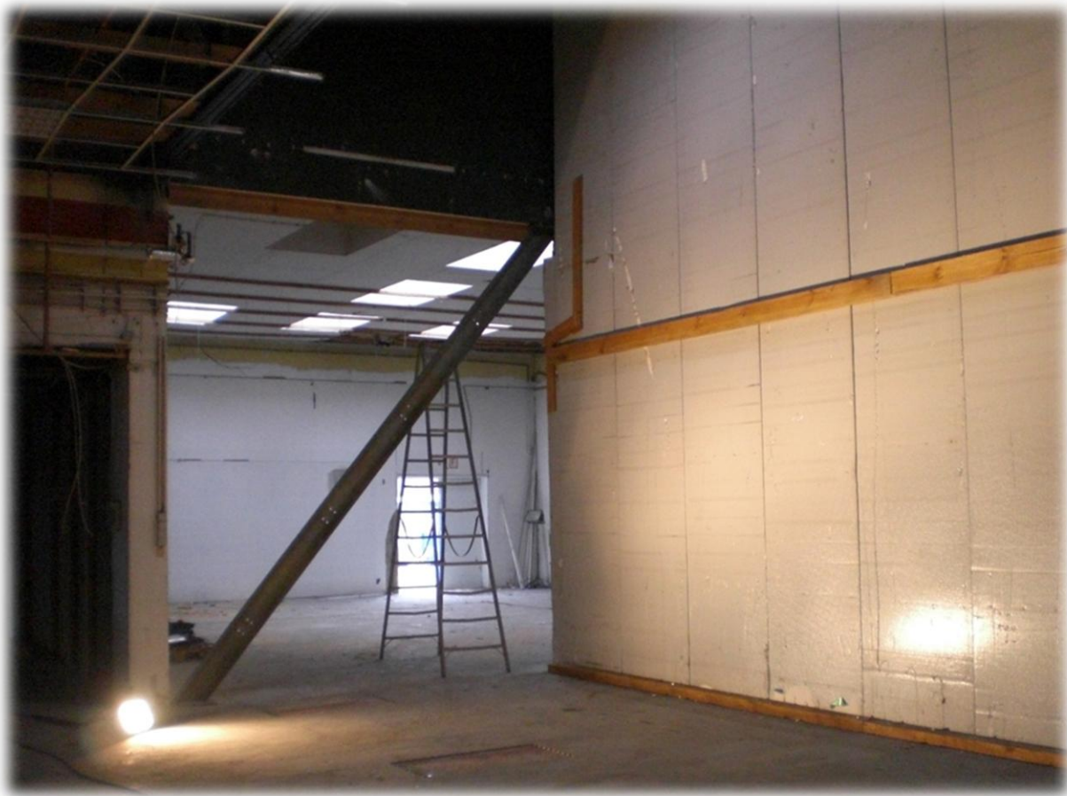
„Notausgang im alten Messebereich“
