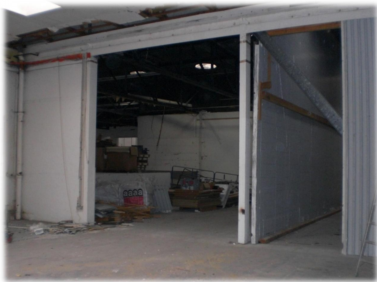
Entstehende Schutzwand für den erhalten bleibenden Bereich...
