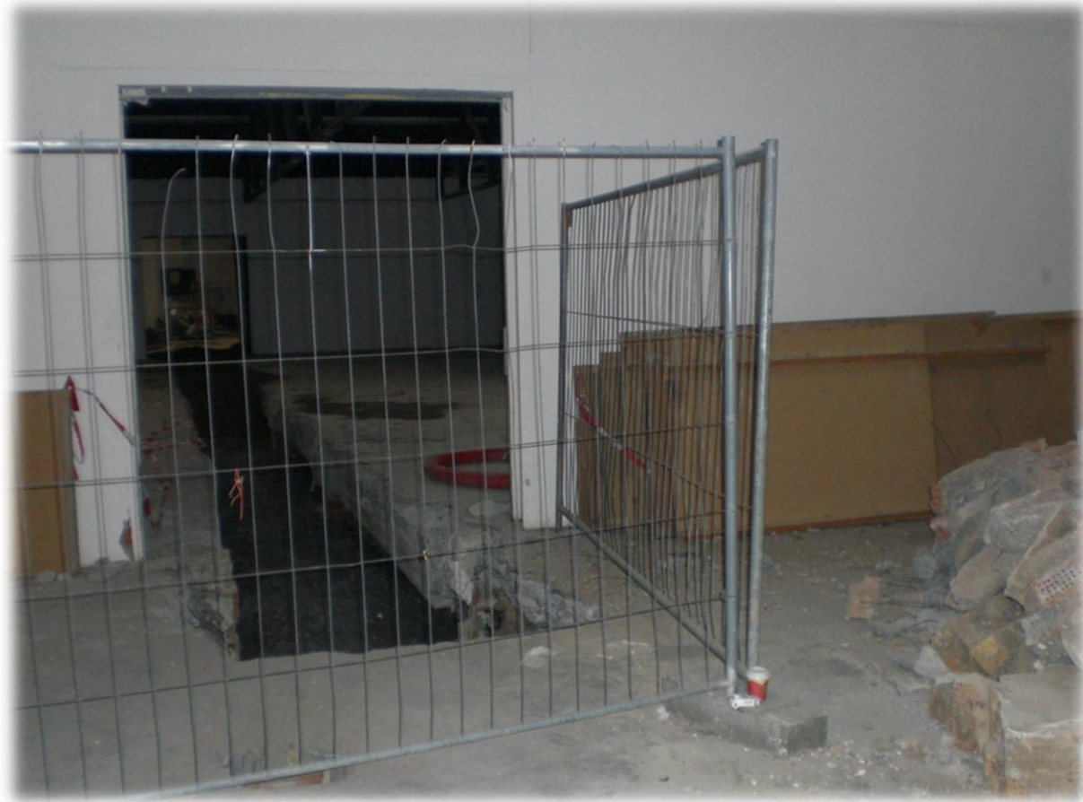
Neue Hauptleitungen unter CE.
