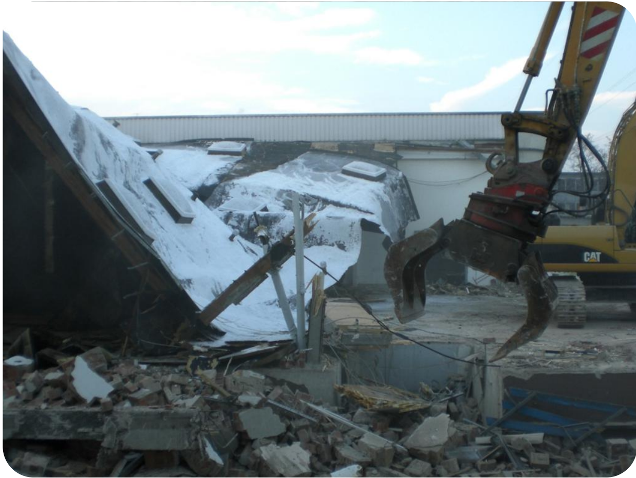
Das Dach kommt runter...
