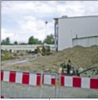
Vom Abriss bis zur Fertigstellung
