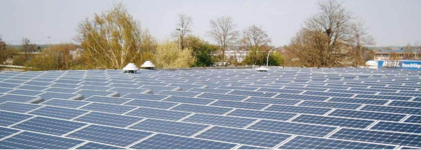
Läuft alles normal, produziert die Photovoltaikanlage auf den Hallendächern am Standort Offenburg rund 150.000 Kilowattstunden Strom
