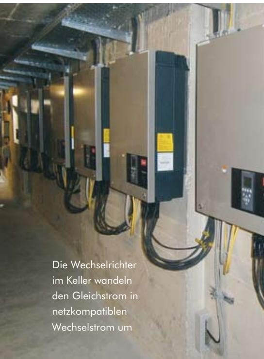
Die Wechselrichter im Keller wandeln den Gleichstrom in netzkompatiblen Wechselstrom um
